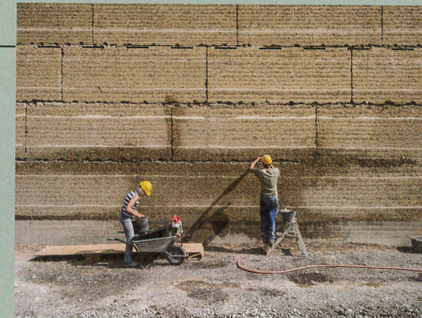
Ricola-Kräuterzentrum in Laufen (2012) von Herzog & de Meuron. Die Elemente der Stampflehmfassade werden zu einer monolithischen Wand durch die mit Stampflehm retuschierten Fugen verbunden.
